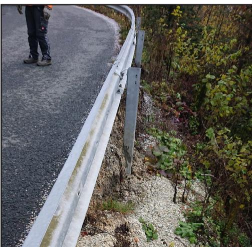
**Im Bereich des Bankettes Bründlweg, vor der Kurve Feistritz Nr. 78, ist es leider durch die extrem steile talseitige Böschung oberhalb der bereits 2018 sanierten Stelle zu einer weiteren Setzung gekommen.**
