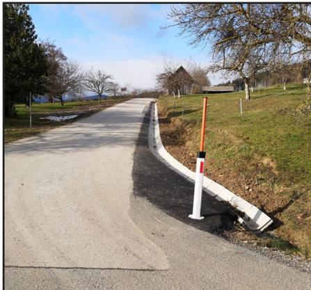
Im Bereich der Hafenscher-Kreuzung sind in regelmäßigen Abständen bei Starkregen und Unwettern die Straßengräben und Bankette ausgeschwemmt. Durch das Setzen von Beton-Halbschalen, zusätzliche Asphaltierungsarbeiten, Ausbaggern der Straßengräben, neue Durchlassrohre und ein Überlaufbecken hoffen wir die Situation entscheidend verbessert zu haben. Mit der Durchführung der Arbeiten wurde die Firma Marko beauftragt. Ein Dank an die Anrainer für das Entgegenkommen.
